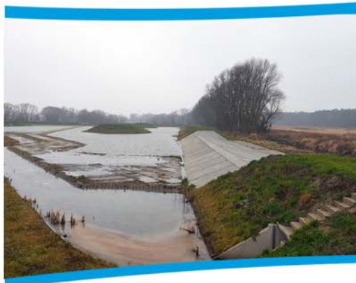
Budowa zbiornika na Strudze Ostrowskiej. Fot. WODKAN S.A.
